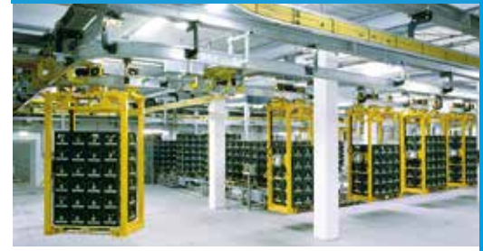
SingleFlexLine 0811 Bira fabrikasındaki elektrikli tek ray konveyör sistemi SingleFlexLine 0811 on an electrified monorail system in a brewery
